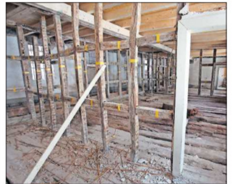
Die Fachwerkwand muss raus, der Boden trägt nicht mehr. FOTO: VAN
