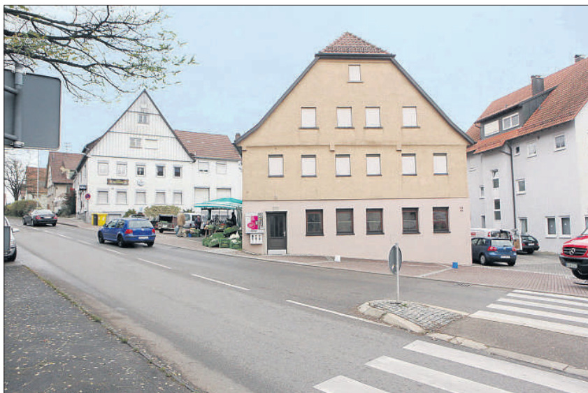
Zähe Planungen: Das „Lamm“ wartet auf den Umbau.
