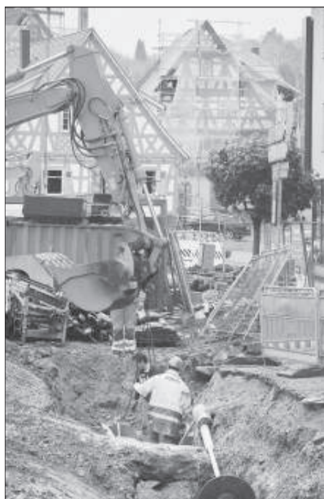
Eine große Herausforderung: Leitungsverlegung bei der Sanierung der Winterbacher Ortsmitte.
