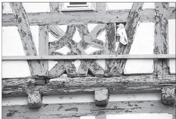
Schmuckfachwerk im Giebel der Nordfassade: Balken und Gefache sind stark sanierungsbedürftig.
